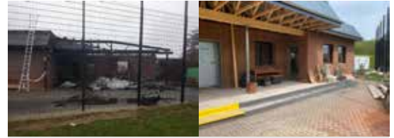
Die Arbeiten am Neubau des Sportheims sind weit fortgeschritten. Ende Juli wird mit der Fertigstellung gerechnet.
